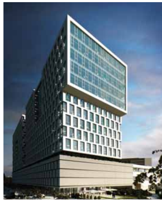
Extensa Offices / Bükreş-Romanya
